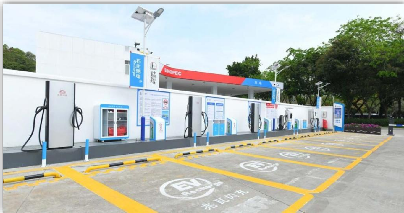
Den nya stationen är belägen i staden Shenzhen.
