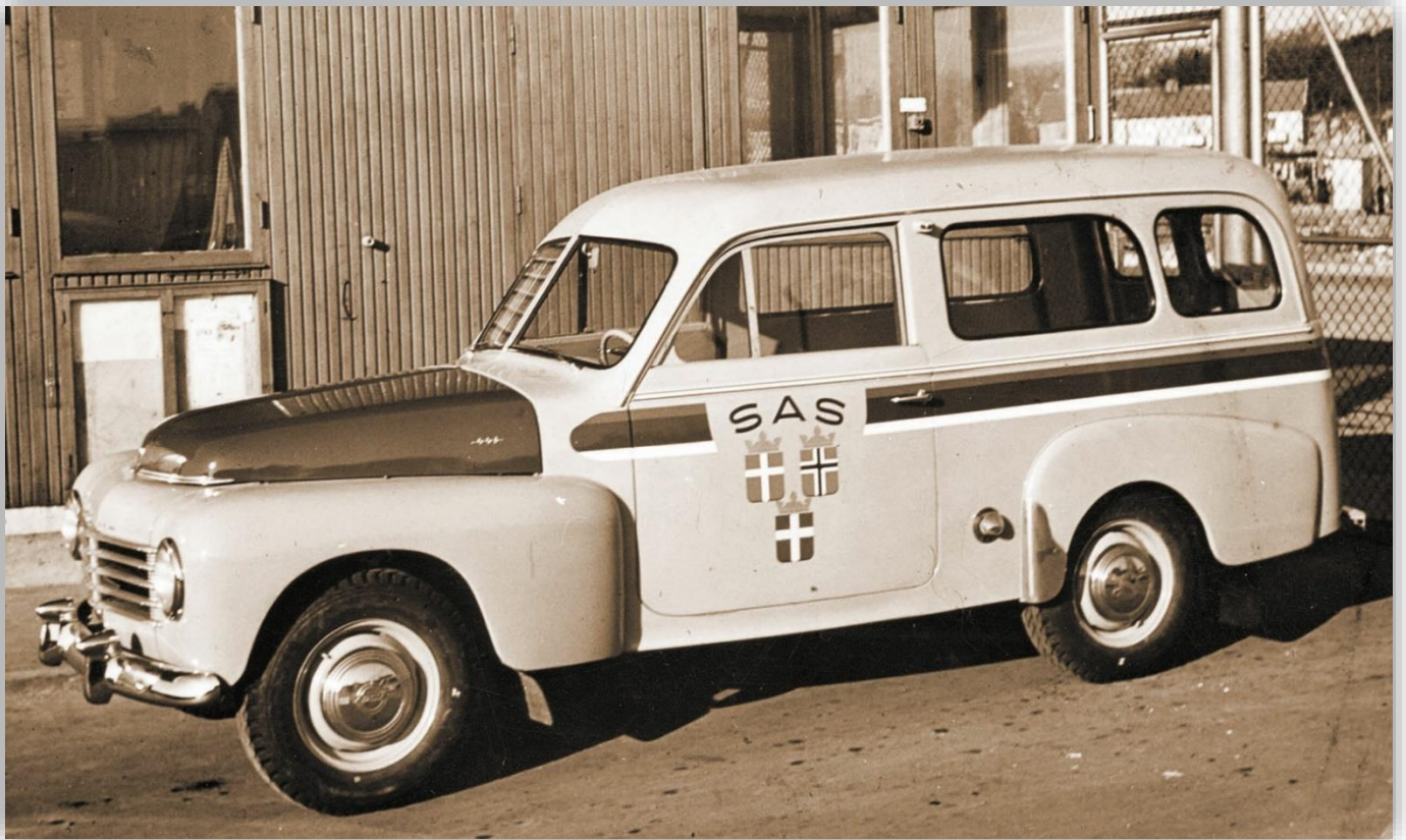
Flera av karossmakarna, exempelvis Grip, valde att montera löstagbara bakskrmar på sina skåpmodeller. De bakre sidorutorna skiljer sig från Volvos egen version.
