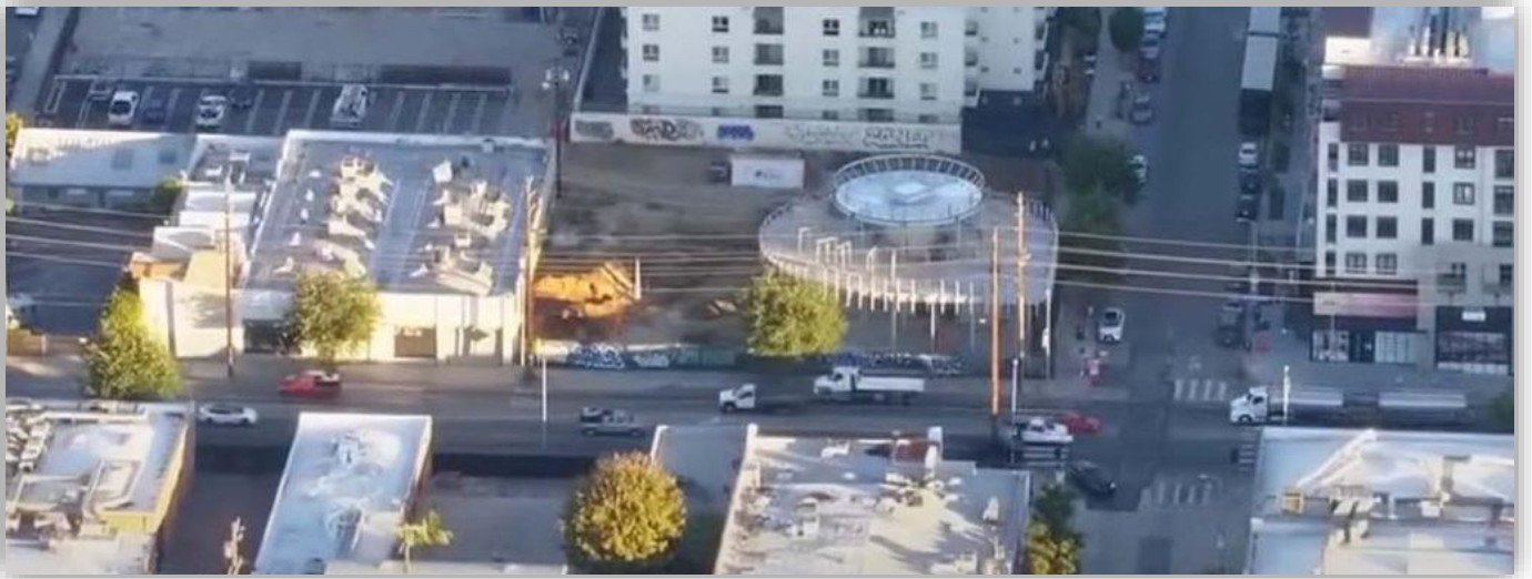
Här byggs den unika stationen.
