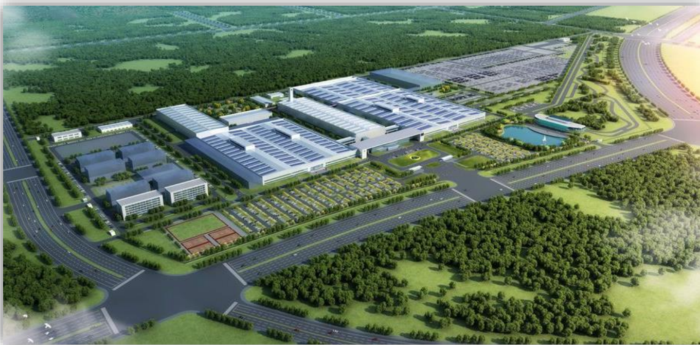
Lotus Technologys nya fabrik i Wuhan ska slå upp sina portar senare i år.
