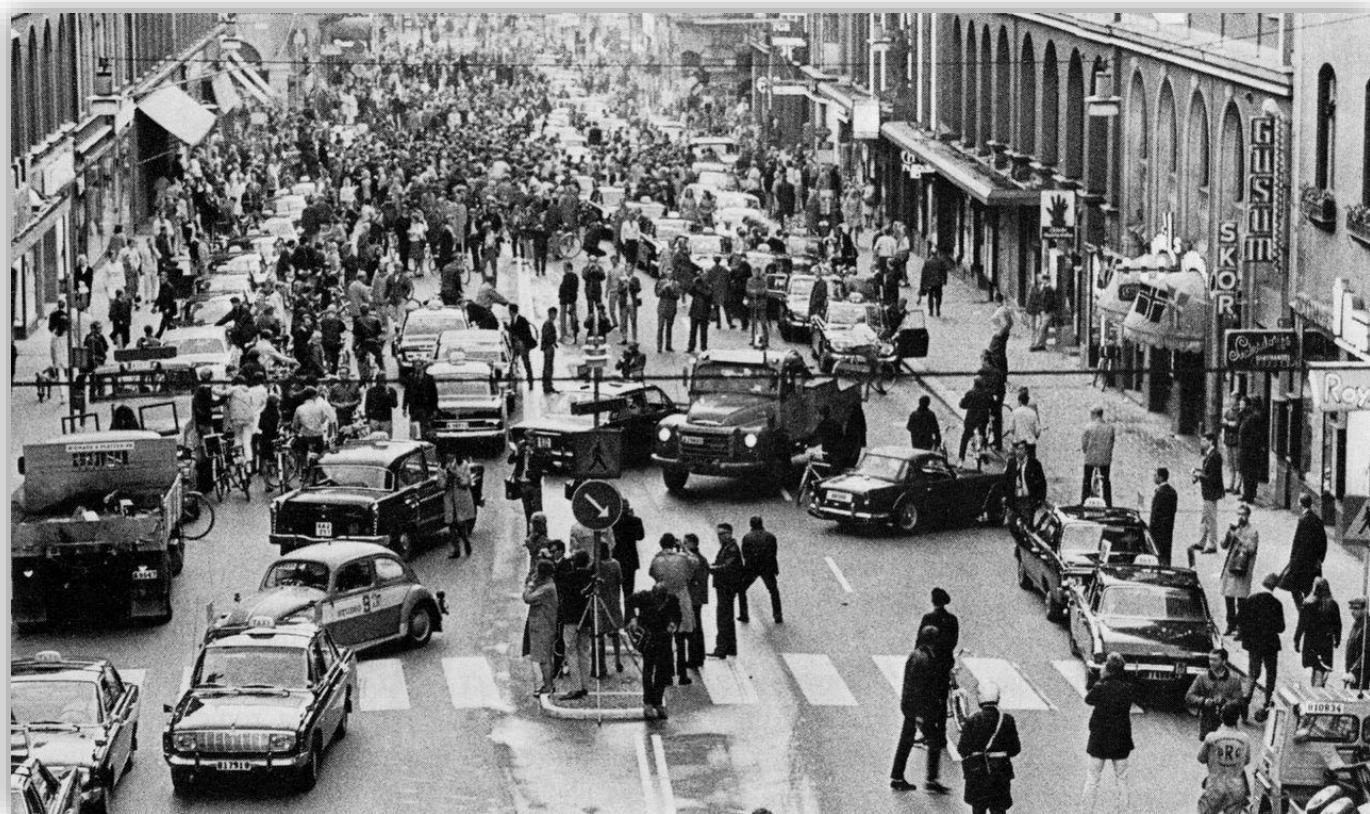
Högertrafikomläggningen på Kungsgatan i Stockholm
