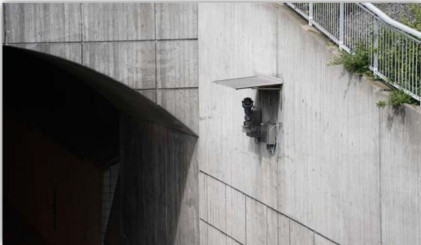
Kamera vid Lundbytunneln.
