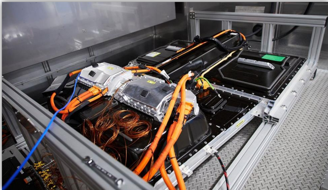
Batteriet från XC40 Recharge inne i ett testskåp.
